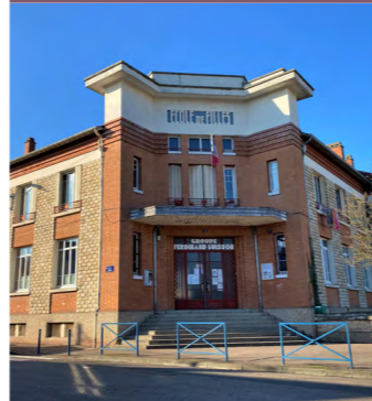
L'école Ferdinand-Buisson est un des plus beaux bâtiments des années 30 à Mantes-la-Jolie.
